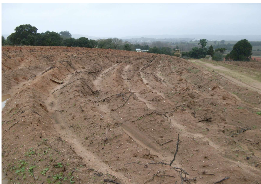
Fig. 6 – Surriba para instalação de vinha
